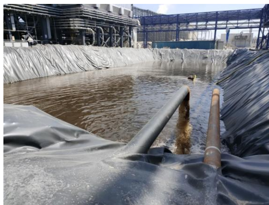
Şekil 4 — Flushing başlangıcı: geçici çökeltme havuzuna kirli su deşarjı (yoğun askıda katı madde).
