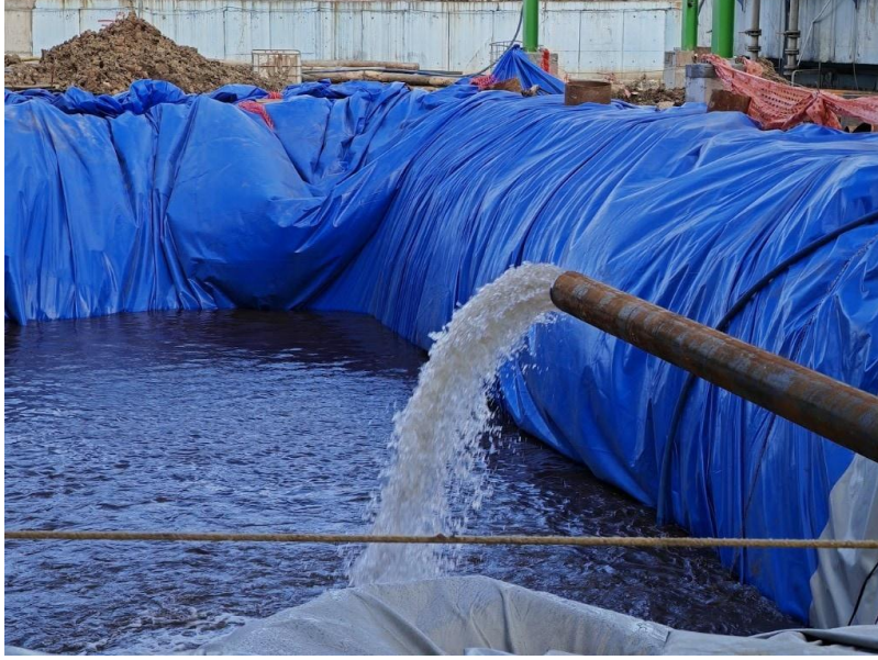
Şekil 5 — Flushing tamamlandı: berrak su çıkış anı (ayrı proje).
